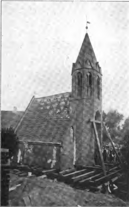
Abb. 29. Die Verschiebung der Jakobskapelle in Brandenburg a. d. Havel im Jahre 1892.
